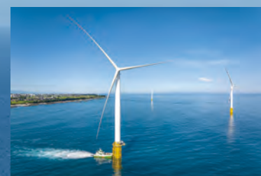
入善町沖洋上風力発電所建設工事 規模 : 9MW (3MW×3基)
